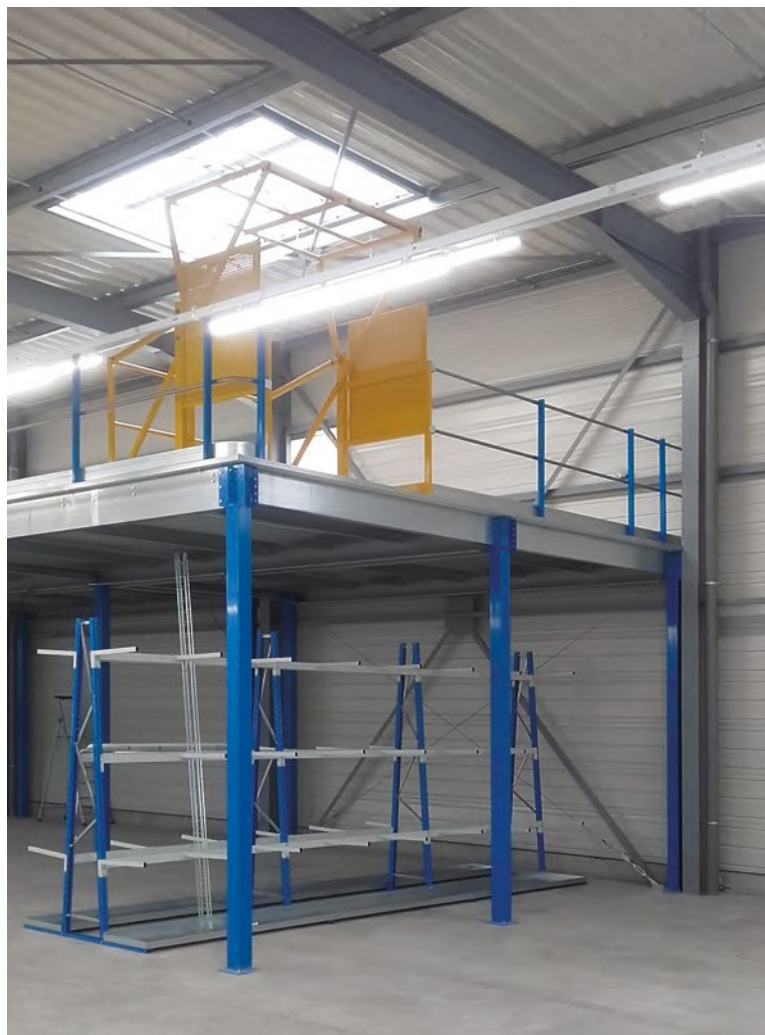
Atelier aménagé avec une mezzanine et un râtelier support de gaines vertical ACTI·VOL double face (DDI)
