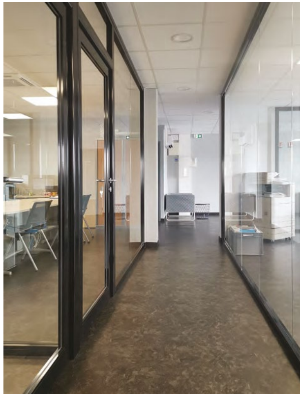
Création d'espaces bureaux avec des cloisons vitrées hauteur plafond (Araydis et GBG)
