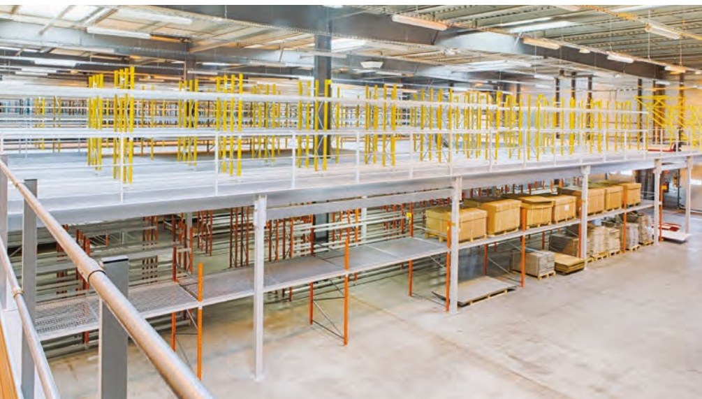
Aménagement complet d'un entrepôt logistique de pièces détachées automobiles d'une surface de 4 000 m 2 , avec des rayonnages installés sur et sous la plateforme (Spade Equipment)
