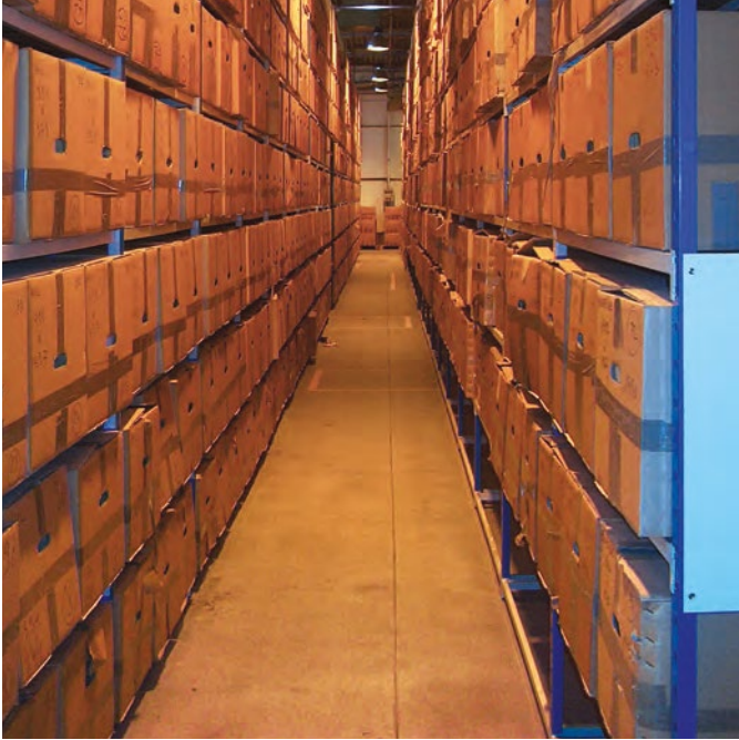
Entrepôt d'archivage organisé en allées de rayonnages grande hauteur pour optimiser l'espace du bâtiment (Avas Equipement)
